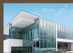
長野県立美術館(本館)外観
